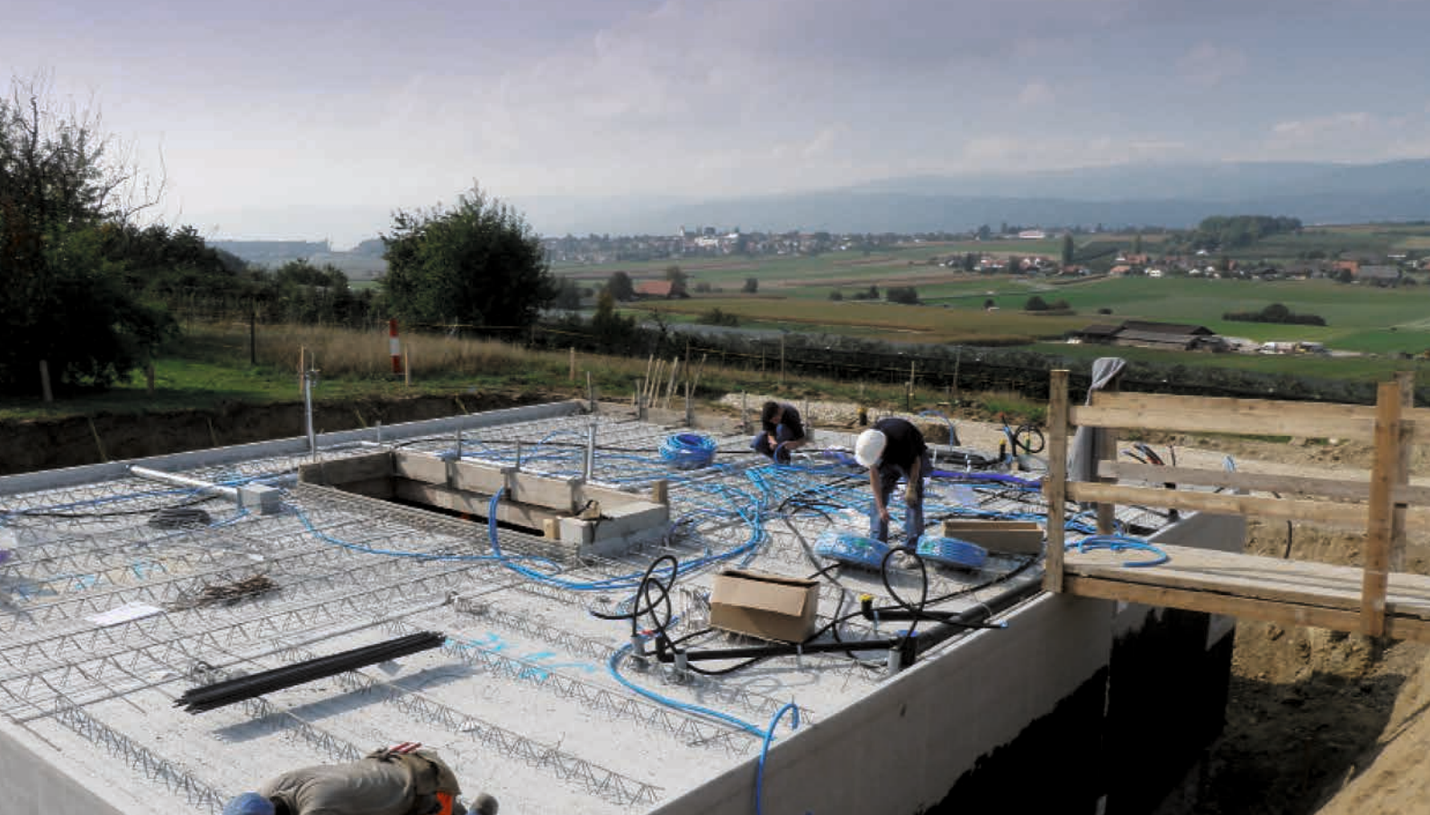
Einlegearbeiten der Sanitär- und Elektroleitungen
