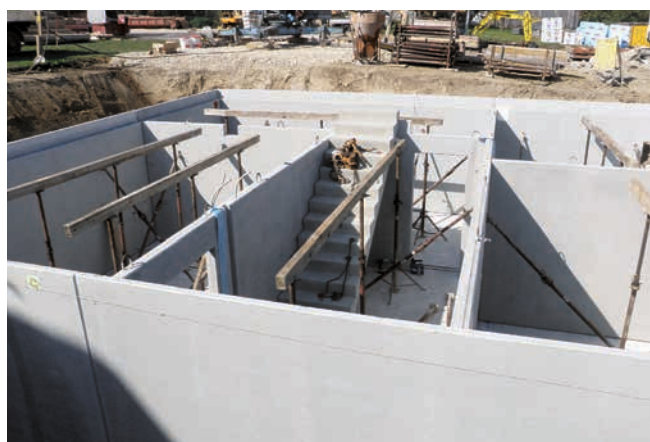
Die Baumeister-Monteur sorgen für den präzisen Wandaufbau
