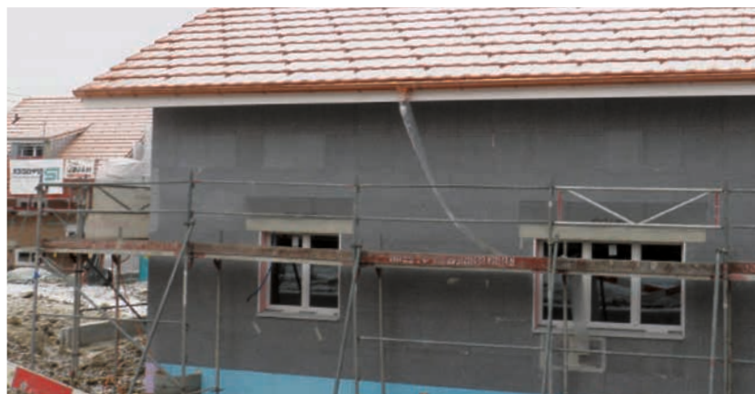
Organisches, schwer entflammables Wärmedämm-Verbundsystem mit Polystyrolämmung
