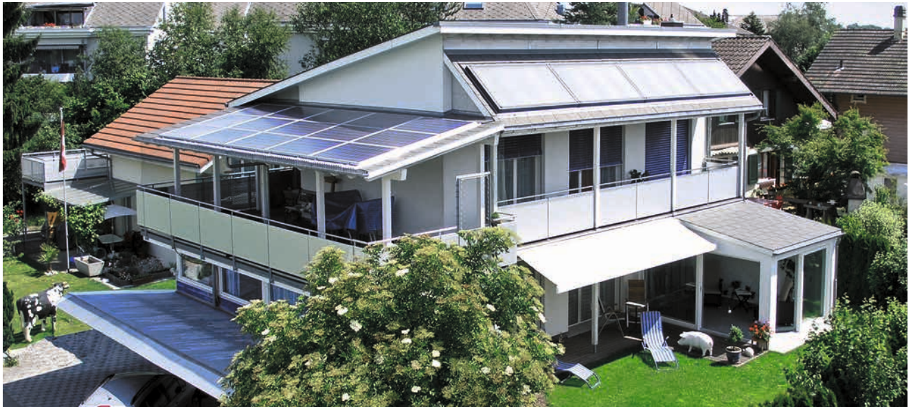
Dieses zertifizierte Minergiehaus haben wir im Jahr 2001 geplant und gebaut
